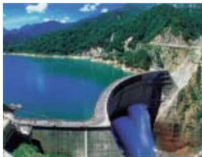
Kurobe Dam (Kansai Electric Power Co.)
